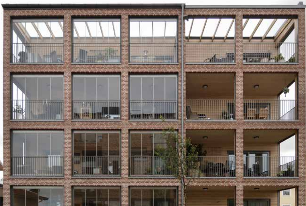
Wohngemeinschaft Vindragaren, mit OrganoWood®-Dielen gebaute Terrasse. Foto von 2017
