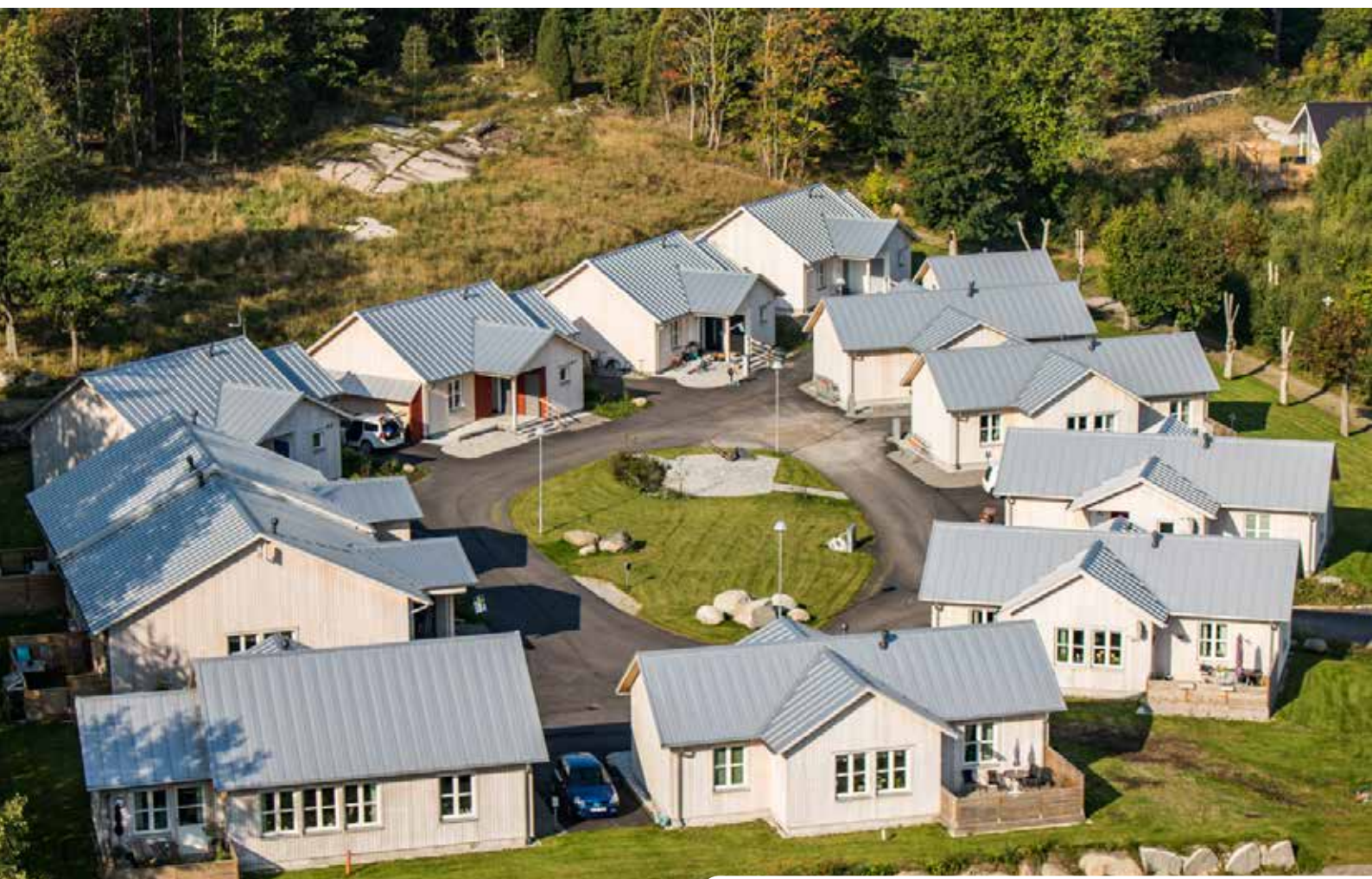
Silverbyn, 12 st hus byggda med OrganoWood® panel. Bild tagen 2017
