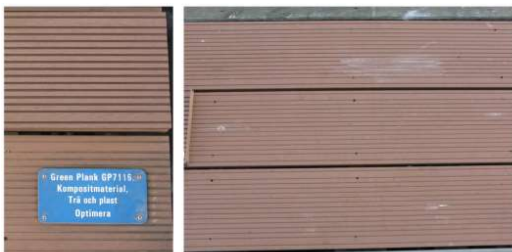
Figur 29. Green Plank GP7116 röd, trä- och plastkomposit.
