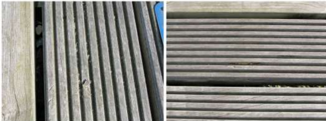
Figur 19. Närbilder av bankirai från senaste inspektionstillfället.
