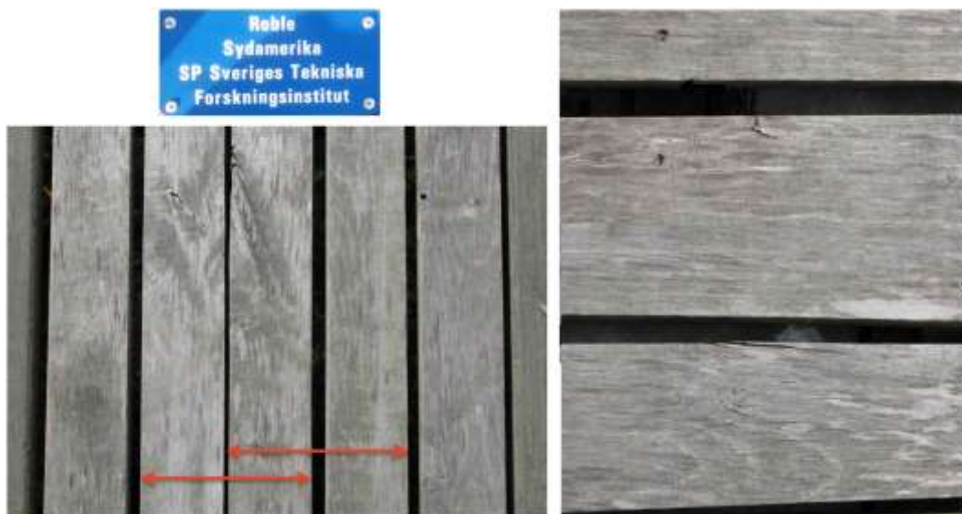
Figur 22. Utseende av robble vid det senaste inspektionstillfället. Observera tecken på dålig dimensionsstabilitet (röda pilar). Viss förekomst av uppfläkning och utstående stickor (till höger). Begynnande röta upptäcktes i skruvhål.
